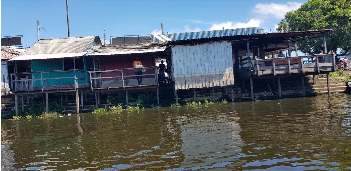
Foto 3 – Vista da Feira do Bagaço, observar parte da Palafitas sobre a escada de proteção de margens
